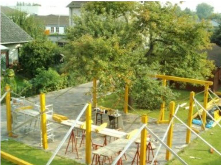
Dieses Bild veranschaulicht glaube ich ganz gut wie wir vorgegangen sind. Die Stützen haben wir natürlich mit den Füßen verschraubt, dafür wurden verzinkte [Schlüsselschrauben](#) verwendet.
