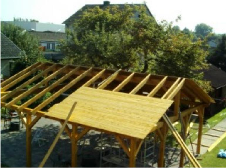
Als die Firstfette stand waren die Sparren an der Reihe, einfach dem Bauplan entsprechend aufgestellt und vernagelt. WICHTIG: Immer schön gleichmäßig links und rechts anbringen, nicht das die First einseitig belastet wird. Als alle Sparren gesetzt waren konnte die Traufenschalung genagelt werden. Vorne und hinten etwas länger lassen und erst hinterher mit einer Handkreissäge passend abschneiden.
